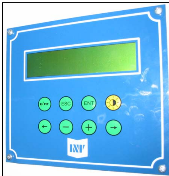
Slika 11. Spoljni izgled displeja za lokalno komandovanje sekcijama elektrofiltera
